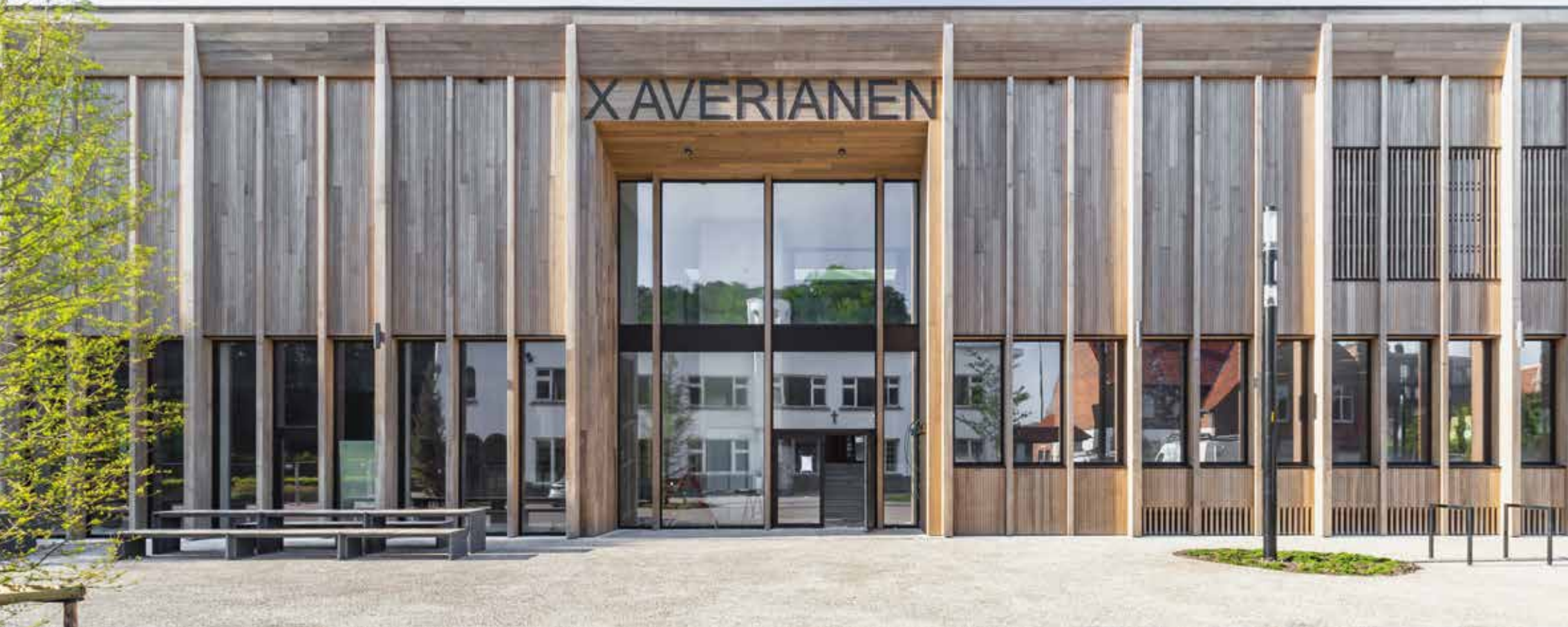
Residence, Eelderwolde (NL) Architectuurstudio SKA Façade cladding, Frames and Blinds Platowood Fraké
